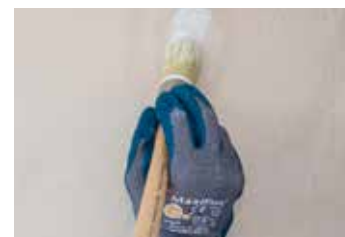
A2 Brossage et impression des lèvres de la fissure.
