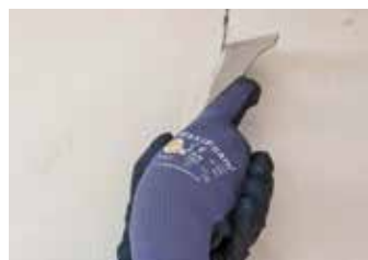
A1 Ouverture au disque ou à la griffe des fissures > 1mm.
