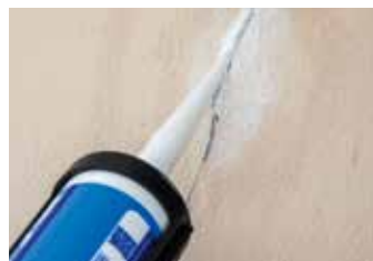
A3 Rebouchage au pistolet de la fissure ouverte avec un produit adapté.
