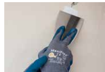
B Cas d'une fissure non ouverte : rebouchage au couteau avec un produit adapté.
