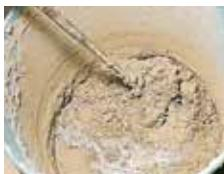
**1** Le mélange PANTICOAT (50%) + ciment (50%) doit être homogénéisé.
