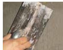
**3** Deuxième passe de lissage avec PANTICOAT (5 mm d'épaisseur maximum).
