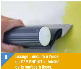
**B** Lissage : enduire à l'aide du CEP ENDUIT la totalité de la surface à lisser.
